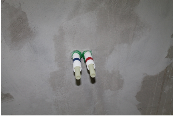
Figur 7 Rör sitter för tätt – tätskikt kan inte monteras rätt.
